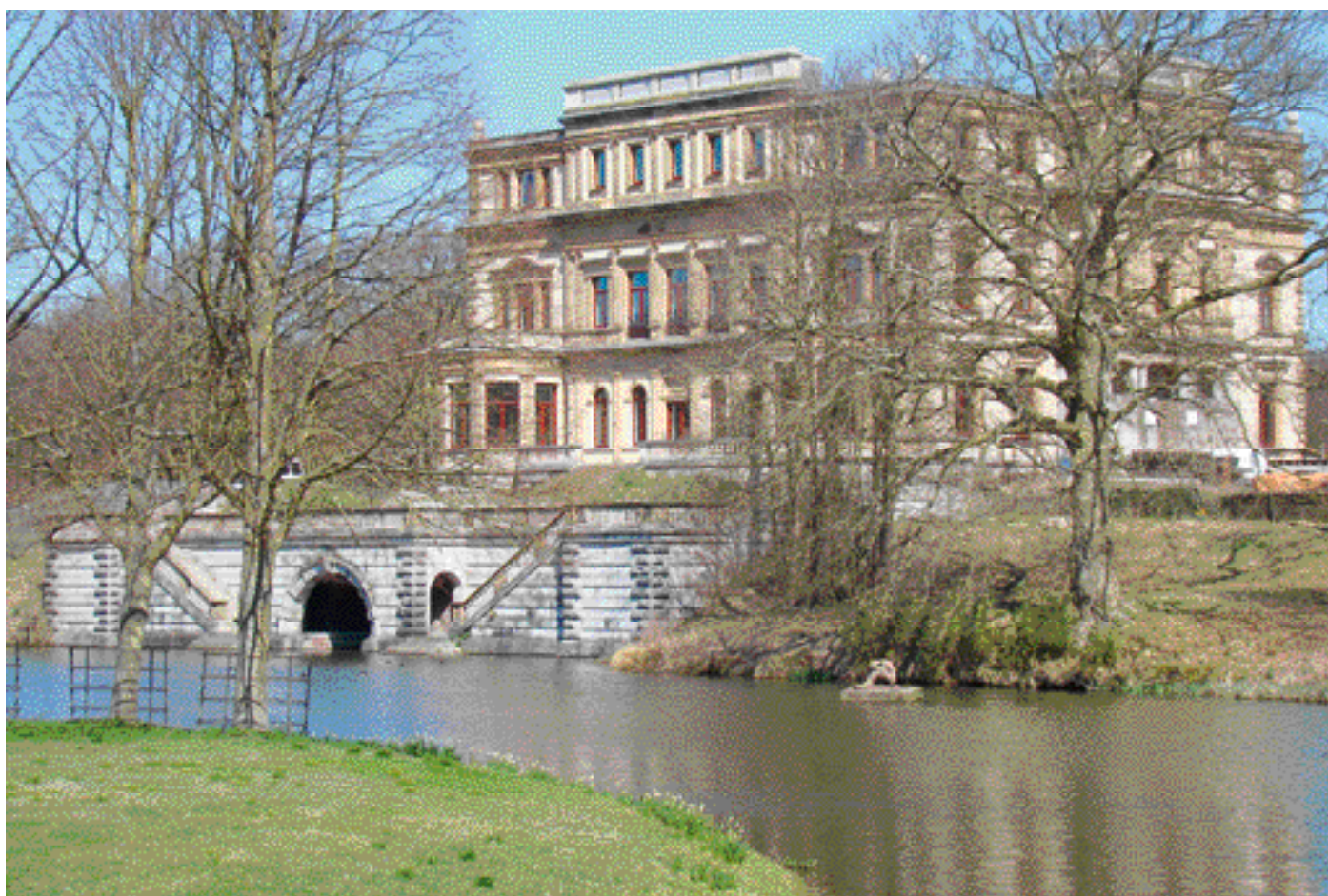
Landgoed Elswout bij Overveen, gezien vanaf de zuidzijde.
